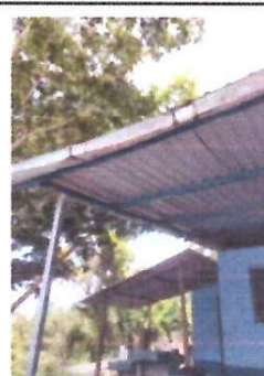
CANALES Y BAJADAS DE AGUA PLUVIAL Sustitución de canales para evacuación de aguas pluviales en mal estado
