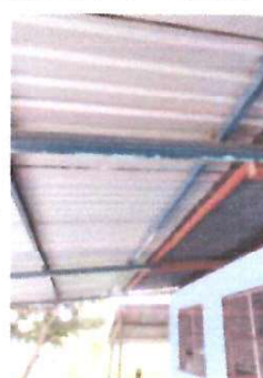
ESTRUCTURA DE TECHO, MANTENIMIENTO DE ESTRUCTURA
